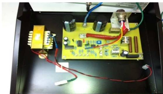
รูปที่ 14 การติดตั้งอุปกรณ์ภายใน
